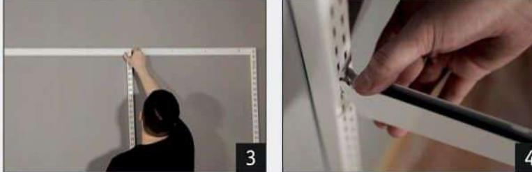
Стойка просто навешивается на рельс и, после монтажа всех элементов системы, прикрепляется к стене.
