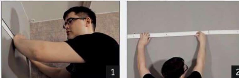
Установка гардеробной системы «Титан-GS» начинается с крепления несущего рельса. Чтобы проверить точность его расположения, рекомендуем использовать строительный уровень.
